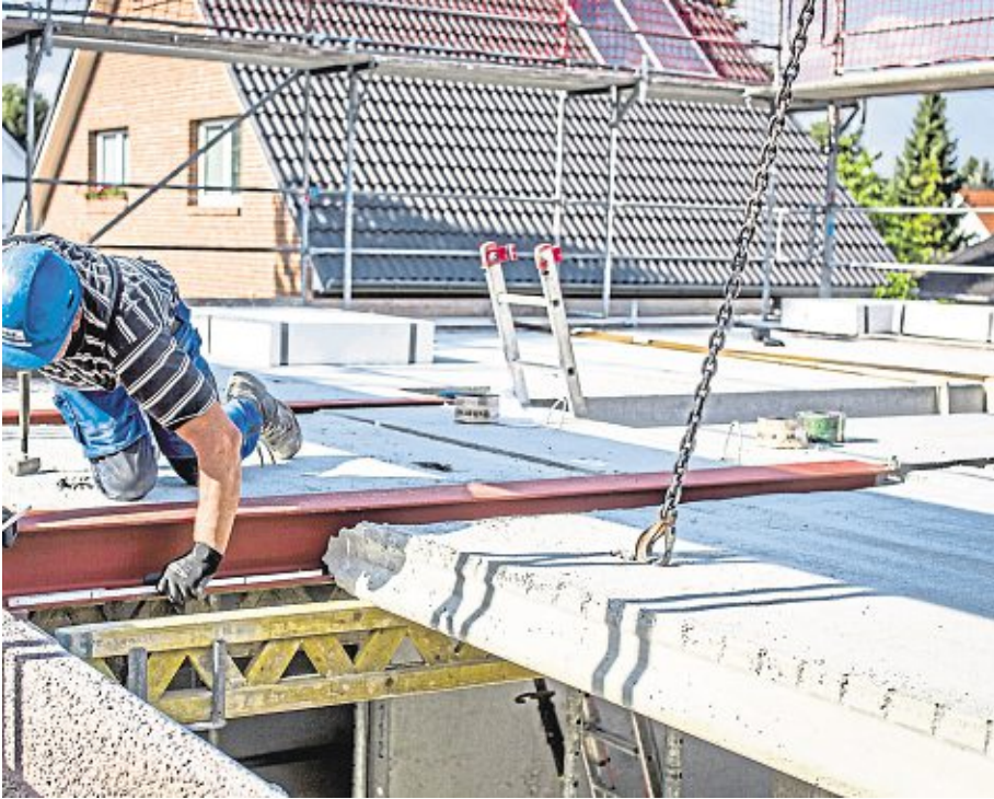
Wer heute ein Haus bauen lässt, muss mit Verknappungen und Verzögerungen beim Materialnachschub rechnen. Foto: djd/Bauherren-Schutzbund
