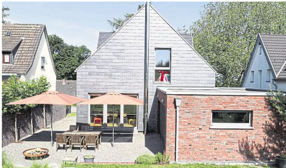
Aus Alt wurde Neu: Thomas Jäger verwandelte einen klassischen Siedlungsbau aus den Fünfziger Jahren in ein modernes Eigenheim. Eine durchgehende Schieferfassade im puristischen Rechteck-Design verbindet nahtlos Alt- und Anbau – und verändert je nach Lichteinfall die Farbe. Fotos: Rathscheck
