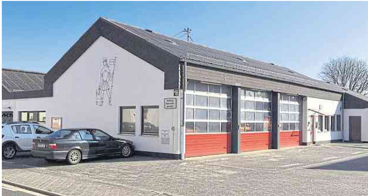
Das bestehende Feuerwehrhaus ist zu eng, es fehlen Räume und die Verkehrsanbindung ist außerdem alles andere als günstig. Foto: Feuerwehr Lindenhofhausen
