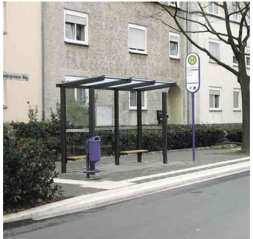
Im Sommer 2018 barrierefrei umgebaute Bushaltestelle Wilhelm-Reitz-Platz in Wetzlar-Niedergirmes. (Foto: Lokale Nahverkehrsorganisation Stadt Wetzlar)
