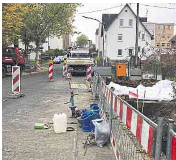
Die vorbereitenden Arbeiten im unteren Teil der Rheinstraße haben bereits begonnen.
