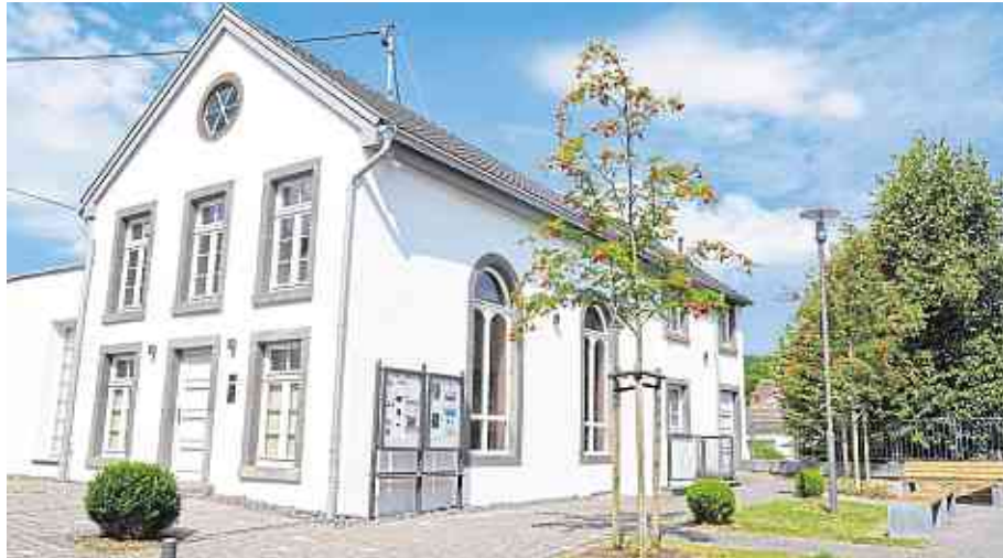
Dank der Arbeit des Kultur- und Heimatvereins Niederzissen können in der ehemaligen Synagoge diverse Veranstaltungen stattfinden. Fotos: Kracht
